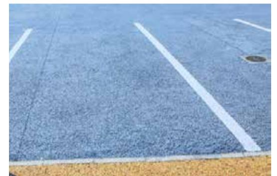
indicado para estacionamentos, acostamentos e pátios, uma vez que o sistema não suporta o tráfego intenso de veículos, ele utiliza o material no lugar do agregado para criar uma superfície com alto poder de drenagem, que impede o empoçamento da água e permite sua reutilização.
