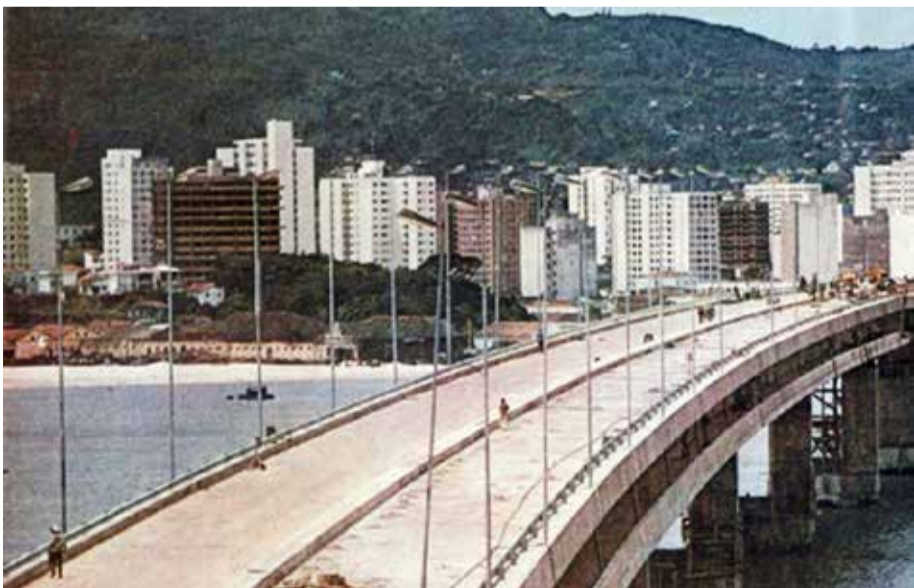
Projeto da ponte Colombo Salles é de autoria do arquiteto Pedro Paulo de Mello Saraiva (1933-2016), natural de Florianópolis (Foto: Arquivo Público do Estado de Santa Catarina)
