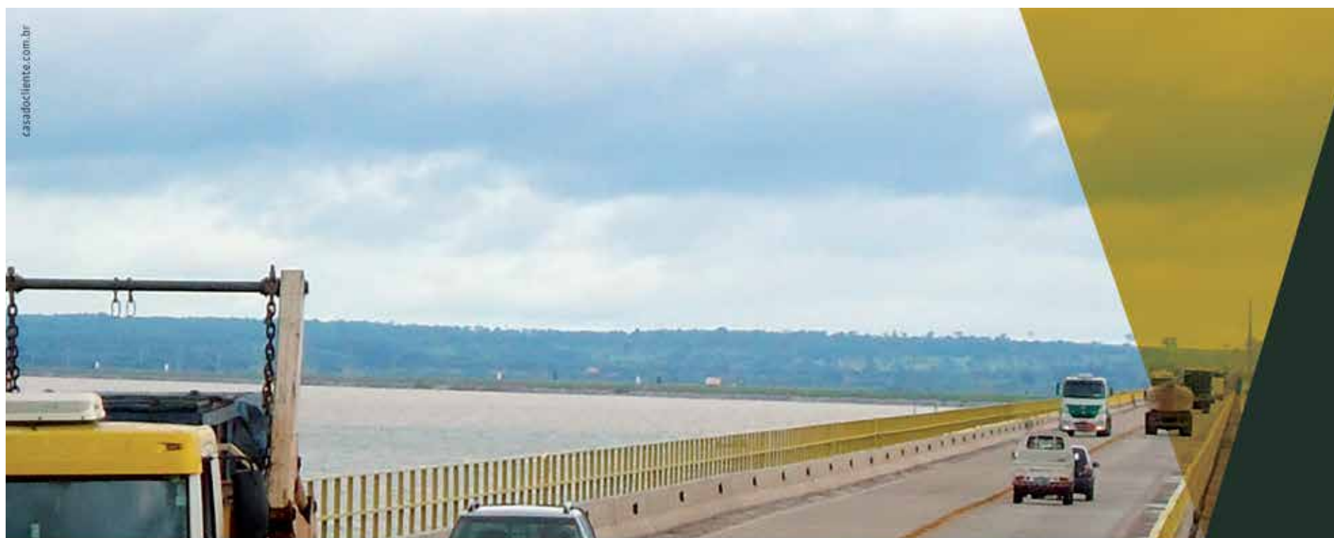
Recuperação da Ponte Maurício Joppert, entre SP e MS
