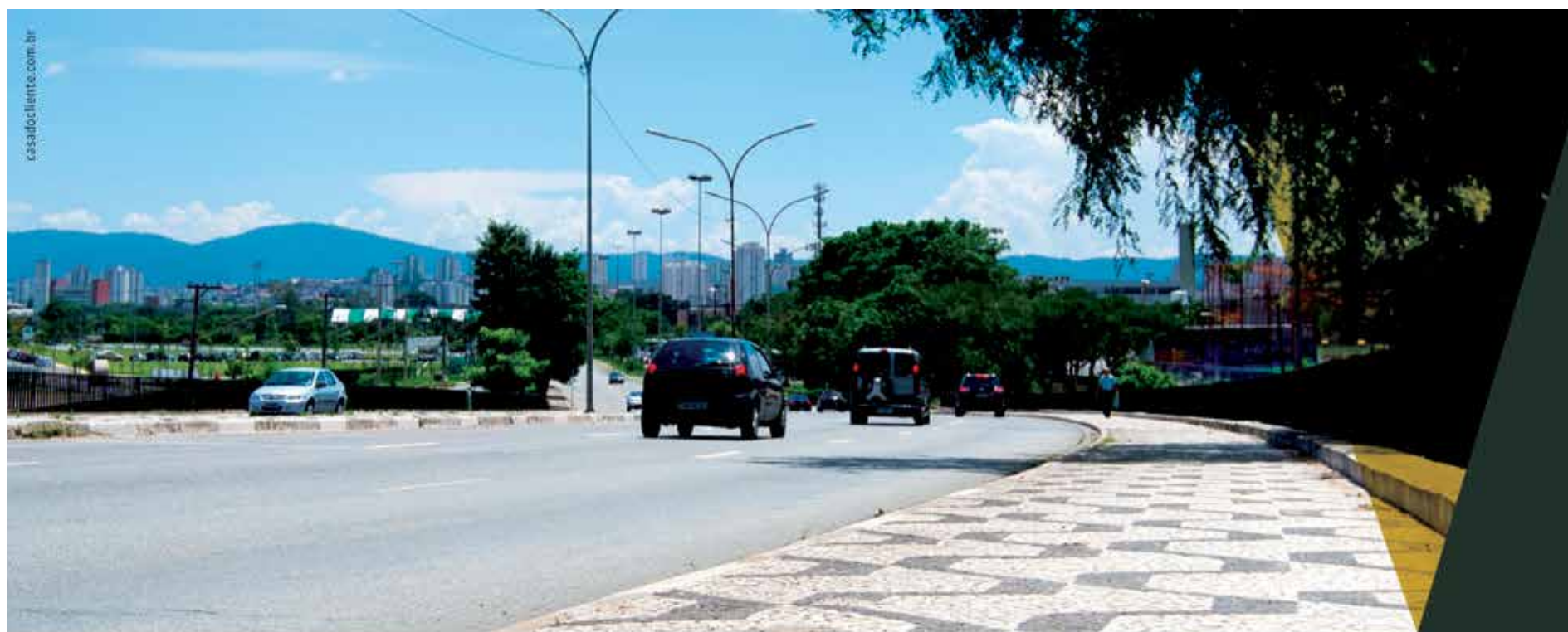
Restauração da Ponte do Limão, São Paulo
