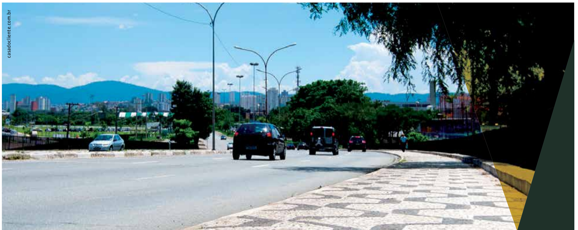
Restauração da Ponte do Limão, São Paulo
