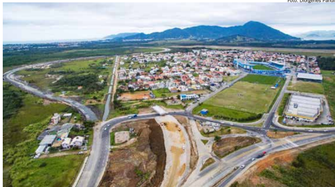
Novo aeroporto terá acesso pelo Carianos, via Diomício Freitas, e à SC-405.
