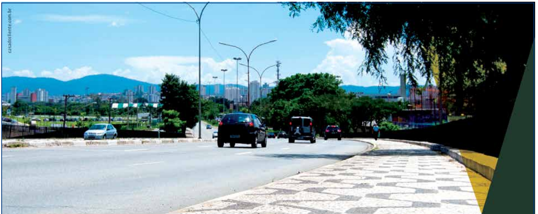
Restauração da Ponte do Limão, São Paulo
